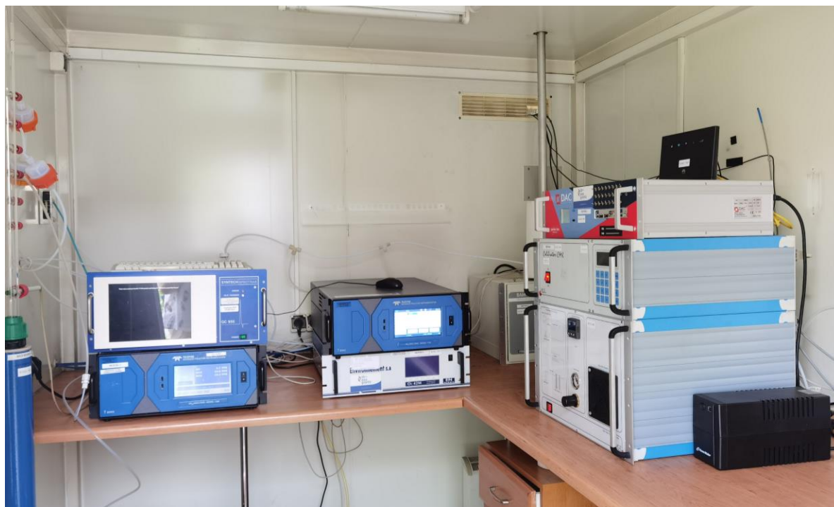
Przykładowe wyposażenie stacji pomiarów jakości powietrza
