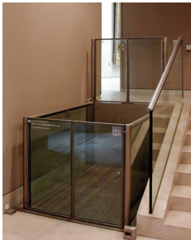
Fot.8 Podnośnik pionowy wewnętrzny, umożliwiający pokonanie schodów w środku budynku. Archiwum Fundacji Integracja
