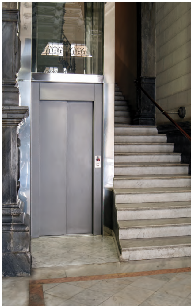
Fot. 1 Winda zbudowana w duszy klatki schodowej, archiwum Global Lift Polska
